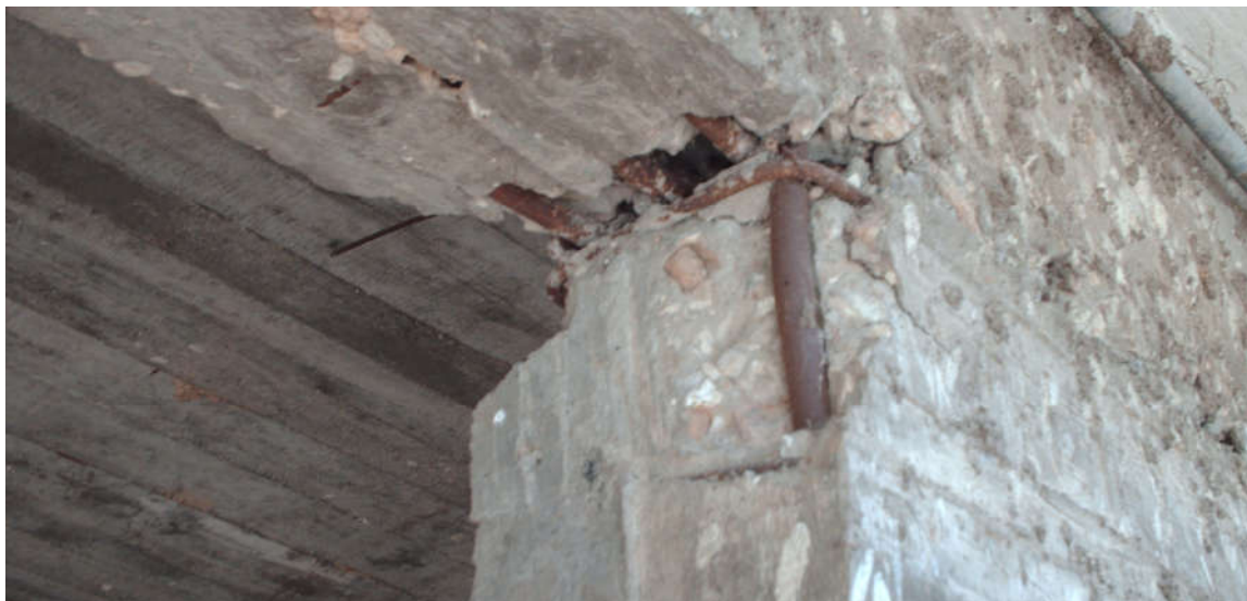
Φωτογραφία 1. Απεικόνιση φωληάς σε κόμβο υποστυλώματος
