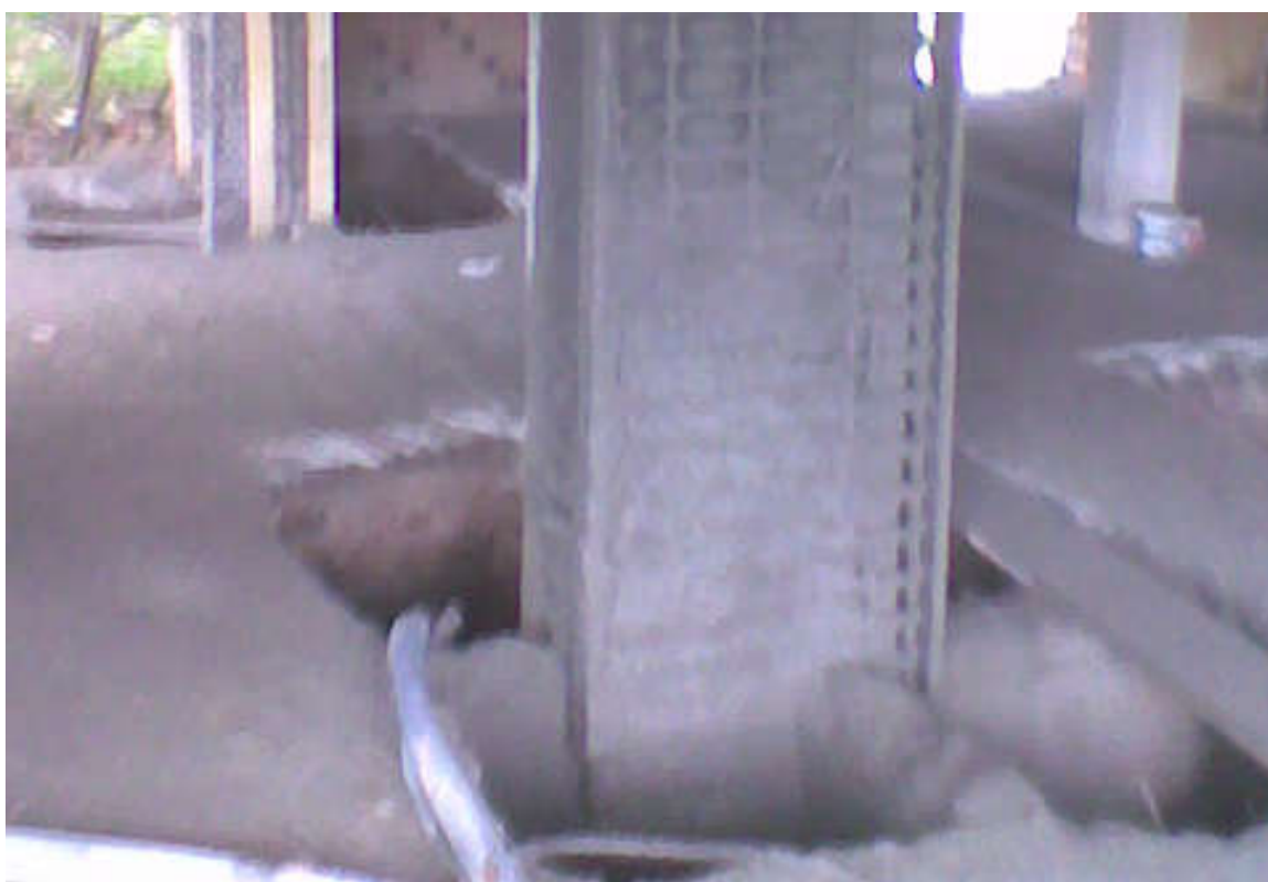
Φωτογραφία 7. Επισκευή στοιχείου σκυροδέματος με gunite.
