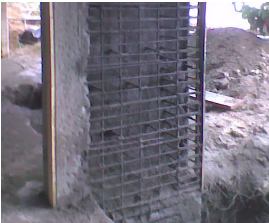
Φωτογραφία 6. Επισκευή στοιχείου σκυροδέματος με gunite.
