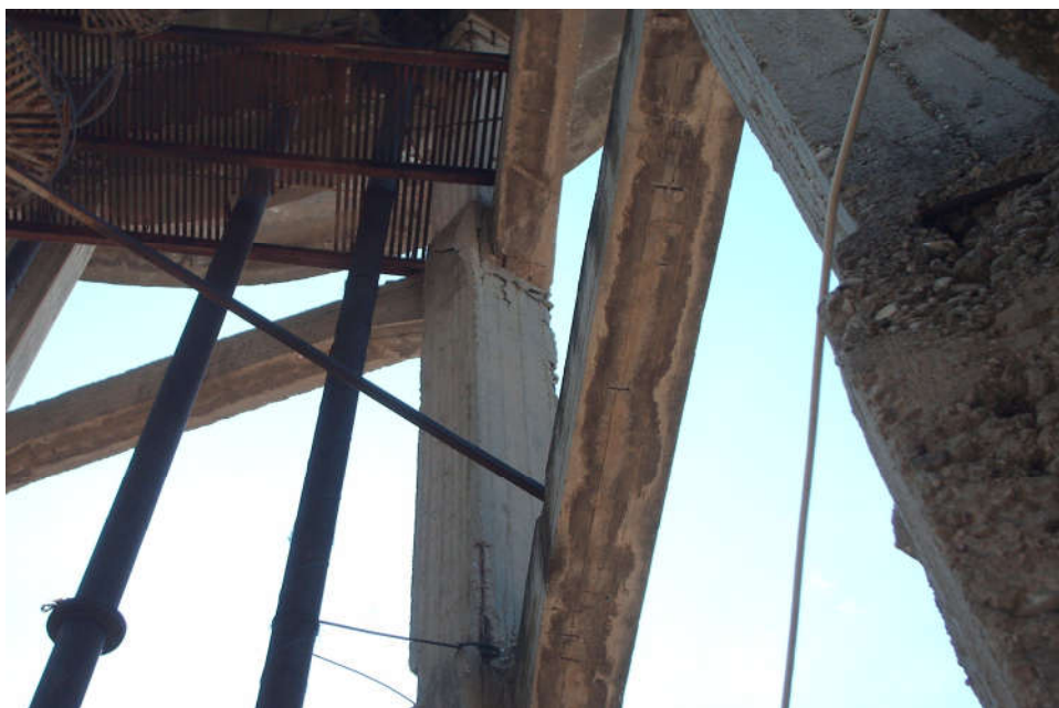
Φωτογραφία 5. Απεικόνιση εκτράχυνσης επιφάνειας λόγω μεγάλης ποσότητας χονδρόκοκκου υλικού.
